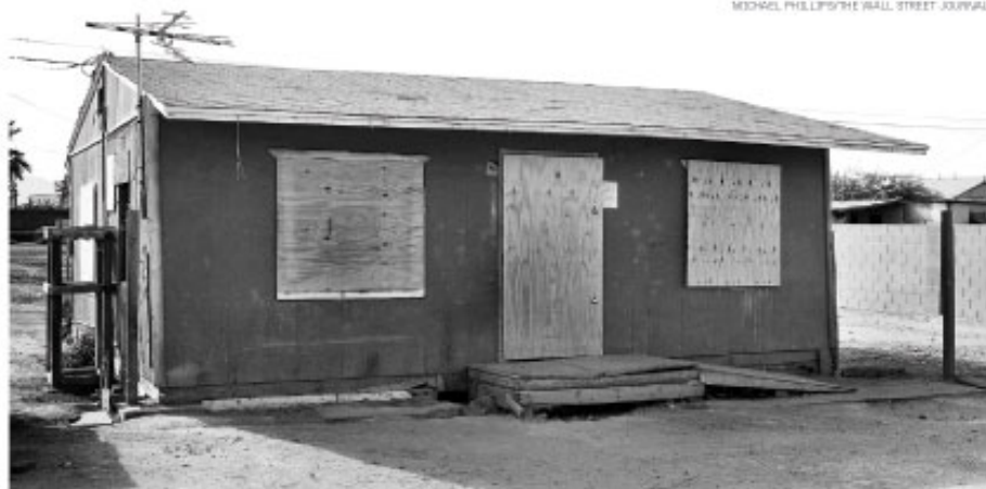
A casa em Avondale que pertencia a Marvene Halterman, adquirida semana passada para ser demolida
